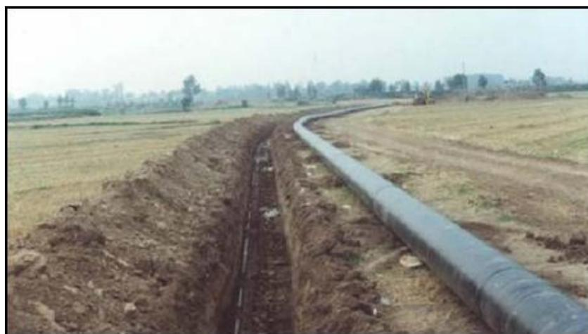
图 3.14-3 国内同类工程管线开挖实景图
